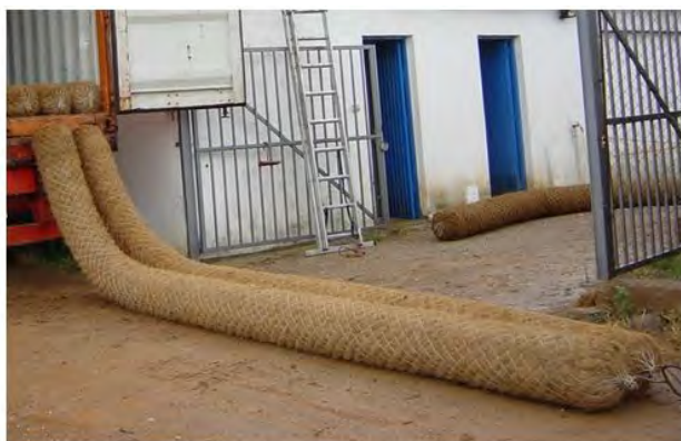
Figure 1.5: Rolls de fibra de coco d'alta densitat sense instal·lar
